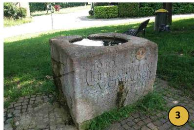
Ursprünglich ein Bodengerinne, das im Rahmen der Flurbereinigung (1951-1957) mit Drainageröhren gefasst und mit Brunnentrog und Zulaufrohr gestaltet wurde.
