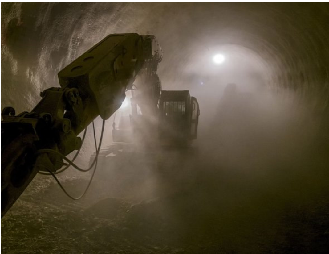
... soll einfach eingetunnelt werden? Fotos: Joachim E. Röttgers
