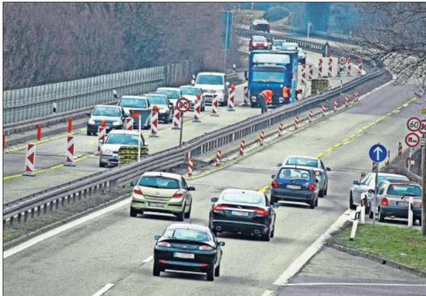
Ob Baustelle (wie hier im Jahr 2011) oder nicht: Die fehlende Einfädelspur zur B 27 ist ein Problem.
