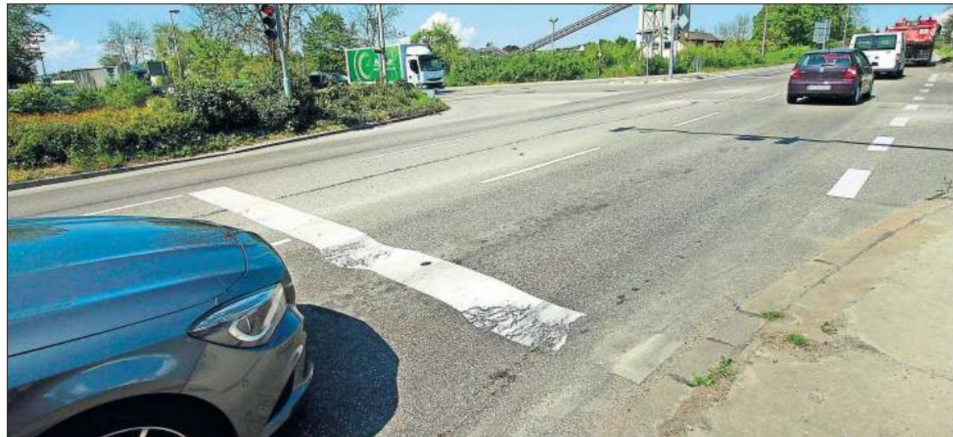
Durch die Remstalstraße in Neckarrems fahren täglich so viele Autos und Lastwagen, dass sich schon Spurrillen in den Asphalt gedrückt haben.
