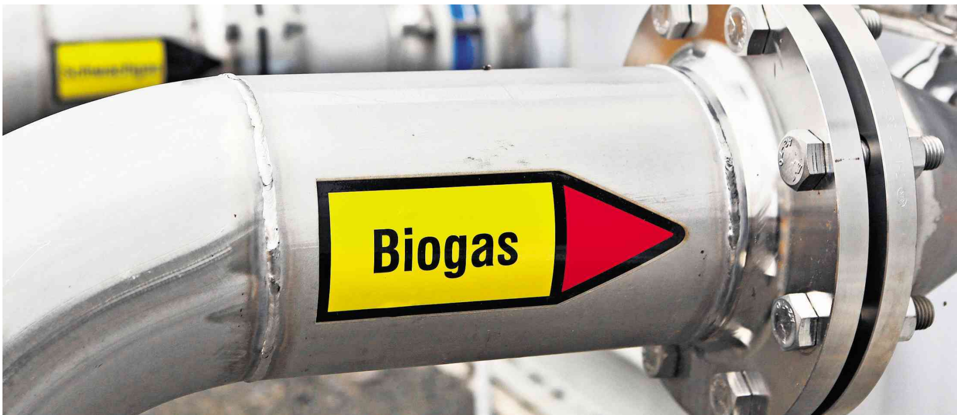
Das nicht zum Eigenbedarf benötigte Biogas wird an die Firma Porsche verkauft.
