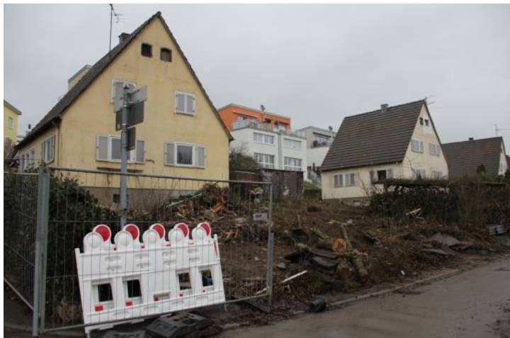
Bereits im Sommer 2018 sollen hier moderne Mietwohnungen stehen. Foto: Bernd Zeyer
