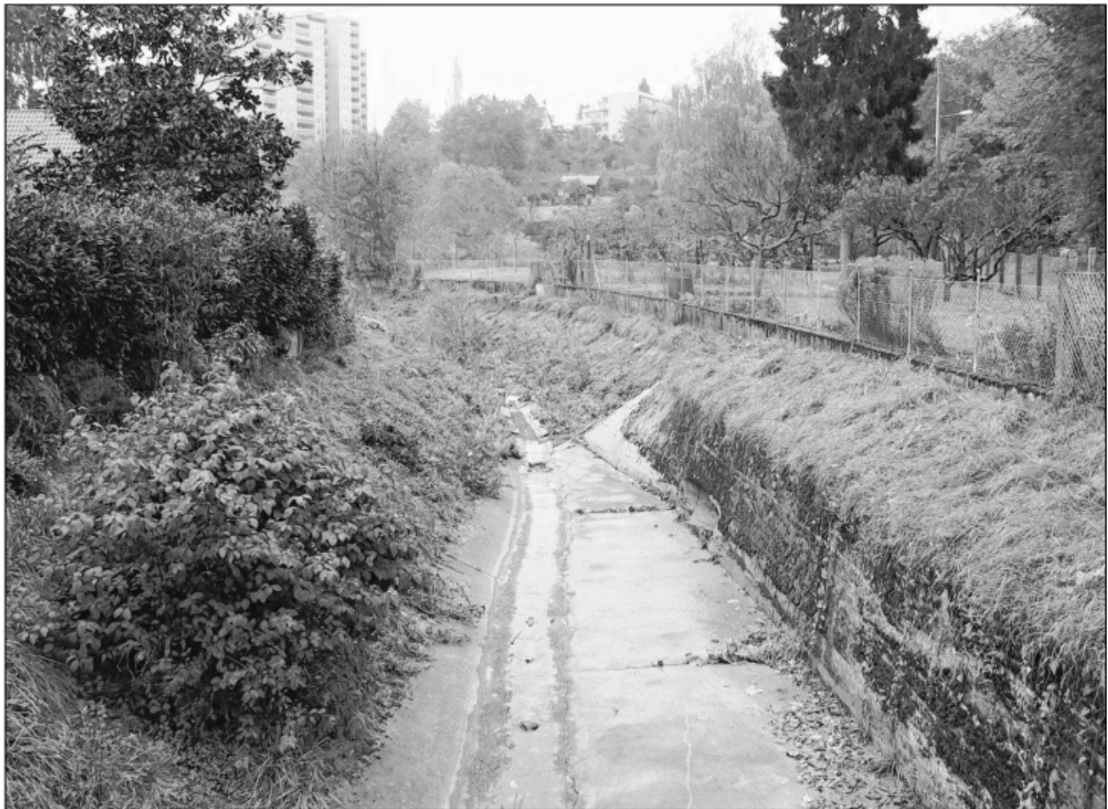
Immer noch fließen einige Abschnitte des Feuerbachs in einem hässlichen Betonbett. Die Renaturierung soll Abhilfe schaffen.
